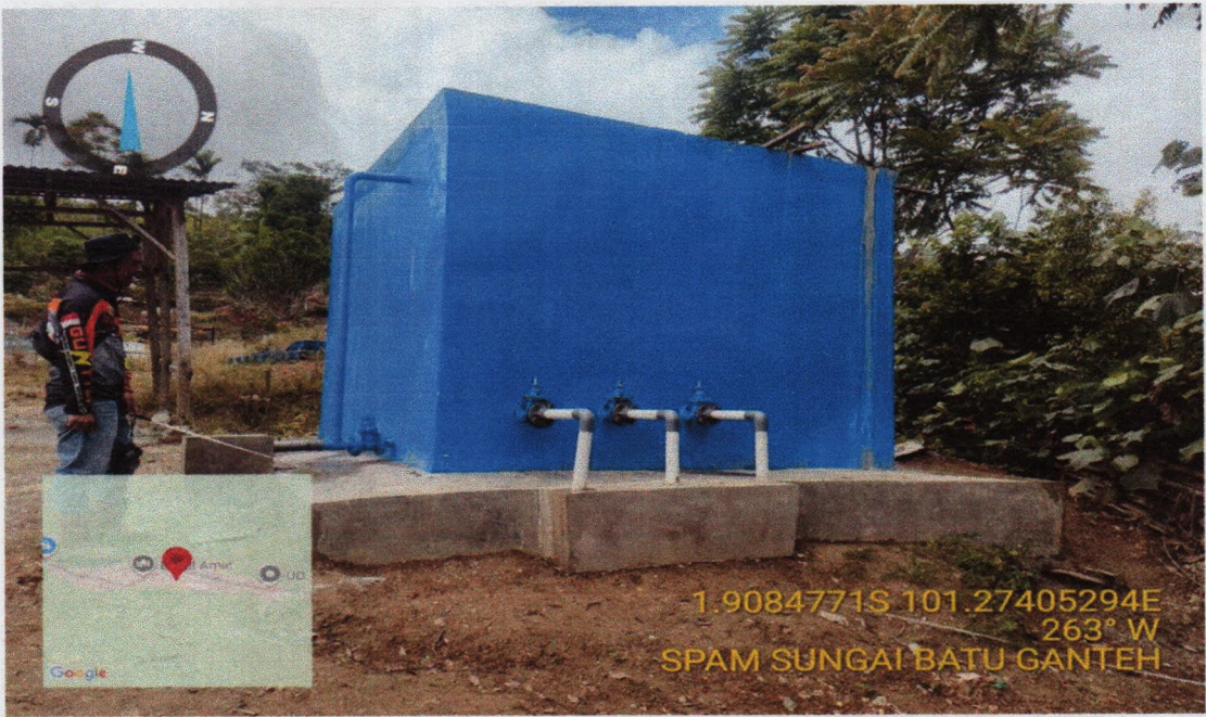
Gambar 3.3. SPAM Sungai Gantih, Kecamatan Gunung Kerinci
